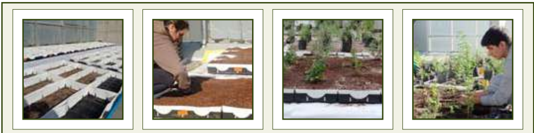
Figura 5. Construcción y plantación de los módulos.
